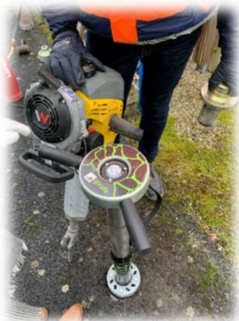
Etape 5 : vérification intermédiaire de la rectitude du pieux dans le sol
