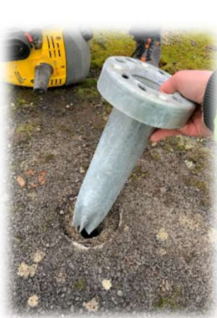
Etape 4 : insertion du pieux d'ancrage dans le sol
