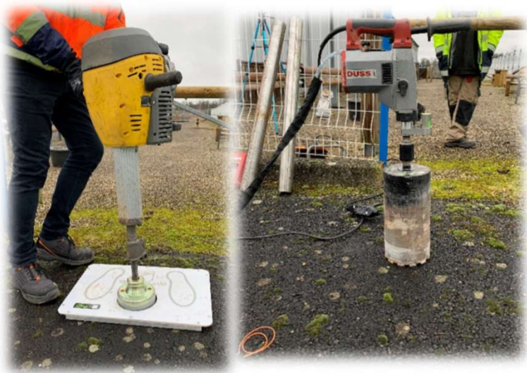
Etape 1 : délimitation par empreinte ou carottage de la zone d'implantation
